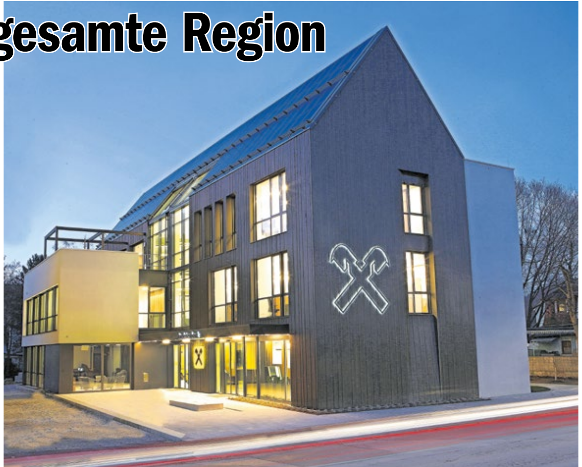
Freundlich und ökologisch gebaut bereichert die neue Raiffeisen-Bankstelle das Ortszentrum von Gratwein. Foto: KK
